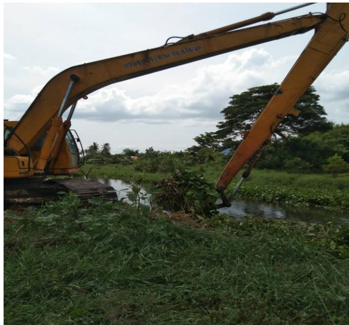
รูปการขุดลอกกำจัดผักตบชวาภายในคลองระบายน้ำ ๑ ซ้ายเจดีย์บูชา ตำบลทุ่งน้อย อำเภอเมืองนครปฐม จังหวัดนครปฐม ระหว่างดำเนินงาน
